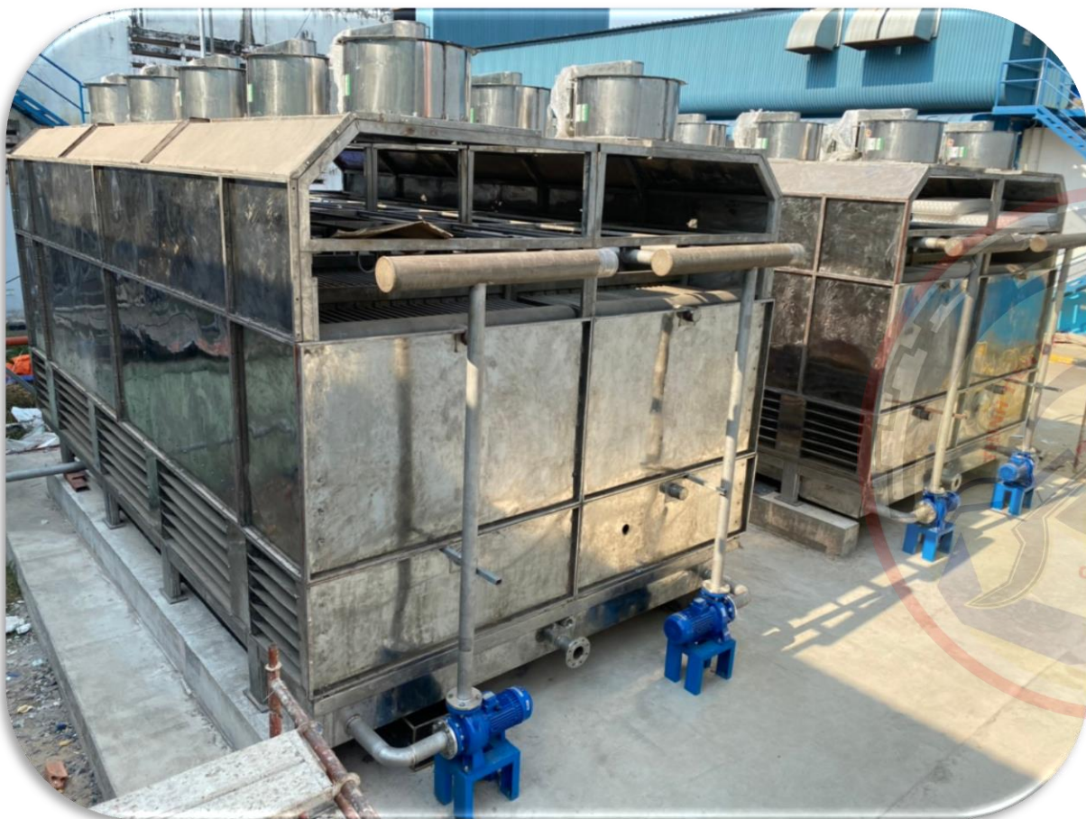
* Lắp hệ thống phun nước cho 02 tháp giải nhiệt.
