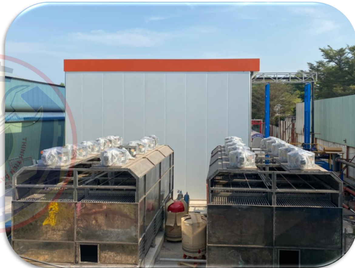
* Cầu lắp hệ thống quạt gió cho 02 tháp giải nhiệt.
