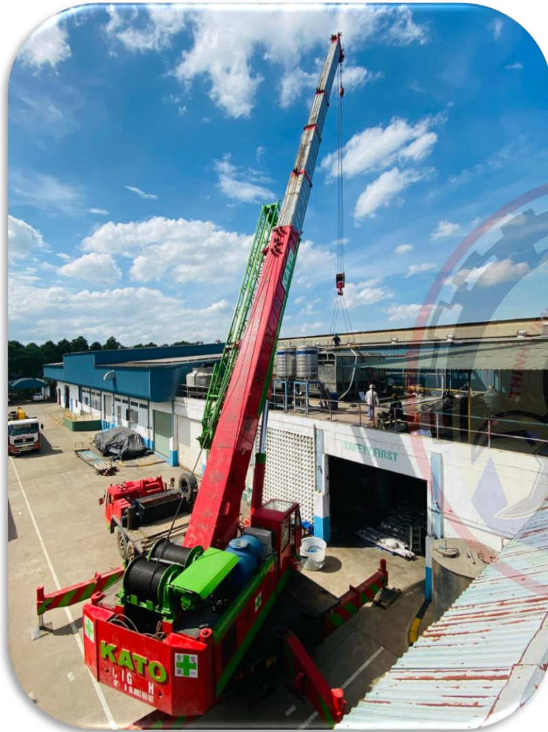
* Cầu lắp 02 bộ tháp giải nhiệt vào vị trí mới.
