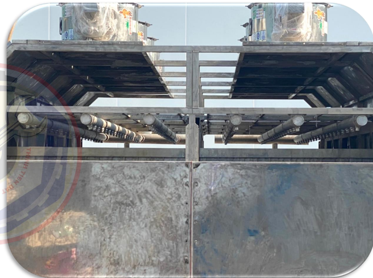
* Lắp hệ thống phun nước cho 02 tháp giải nhiệt.
