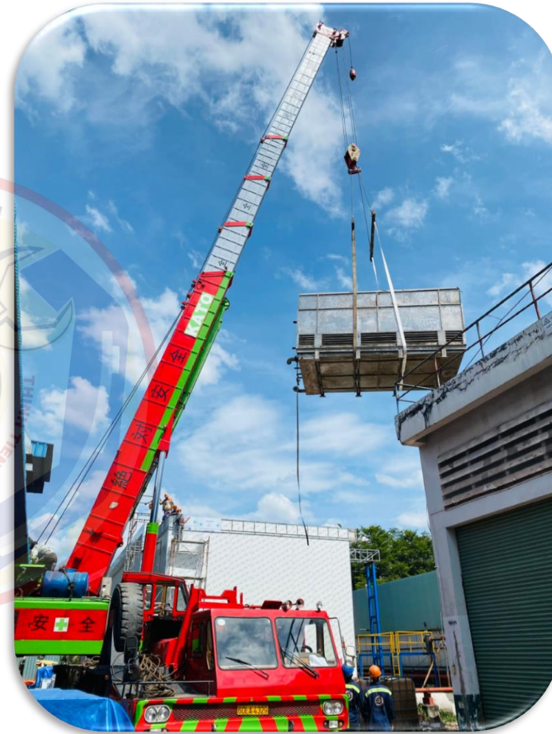
* Cầu lắp 02 bộ tháp giải nhiệt vào vị trí mới.
