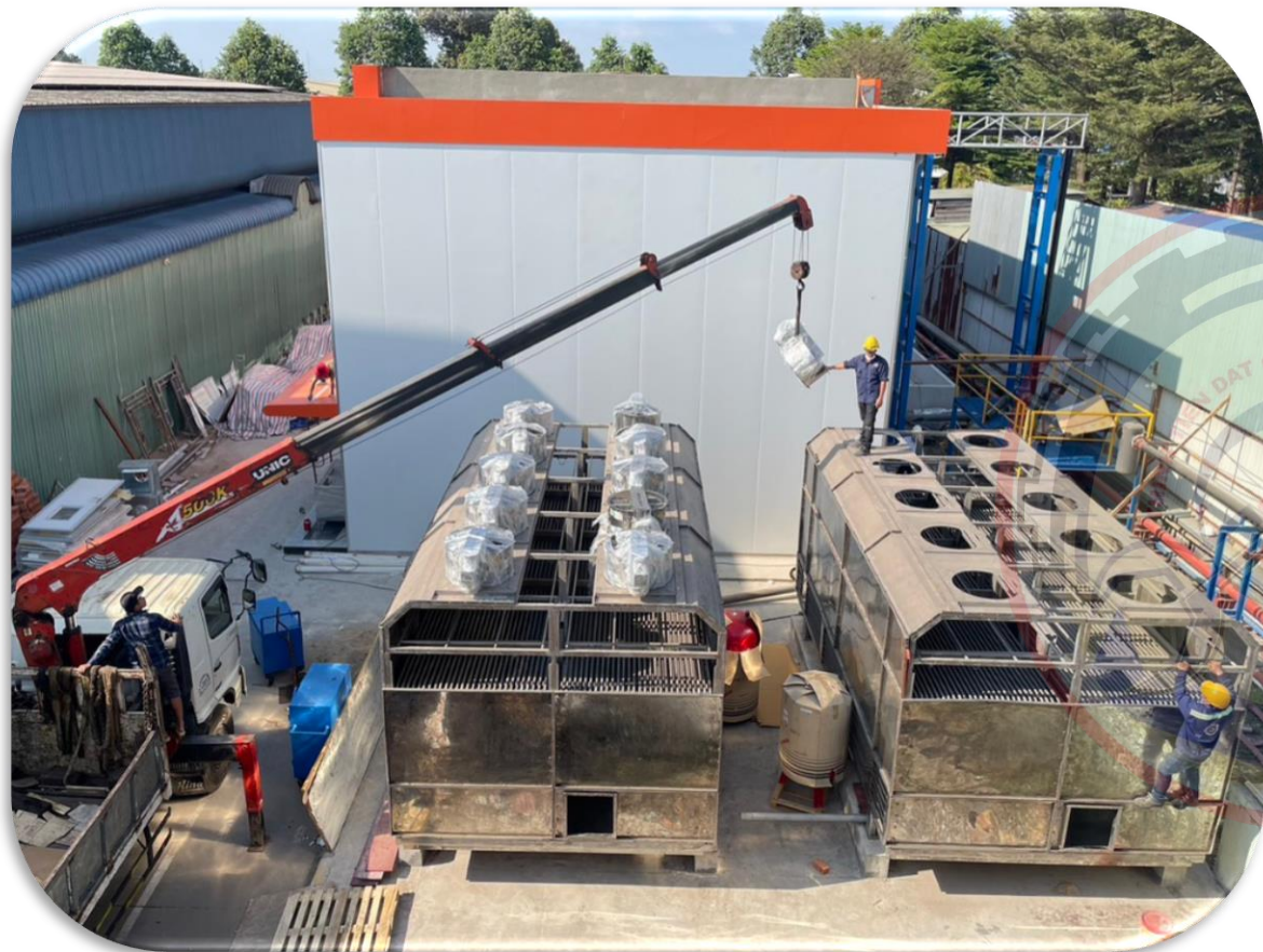
* Cầu lắp hệ thống quạt gió cho 02 tháp giải nhiệt.
