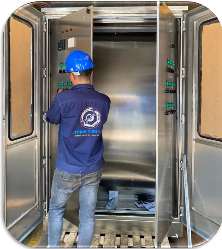
* Cung cấp & lắp đặt tủ điều khiển cho HT tháp giải nhiệt.
