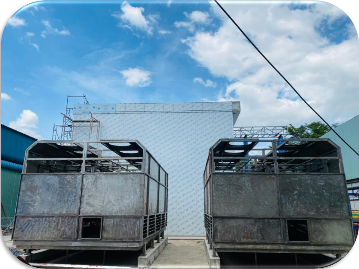
* Cầu lắp 02 bộ tháp giải nhiệt vào vị trí mới.
