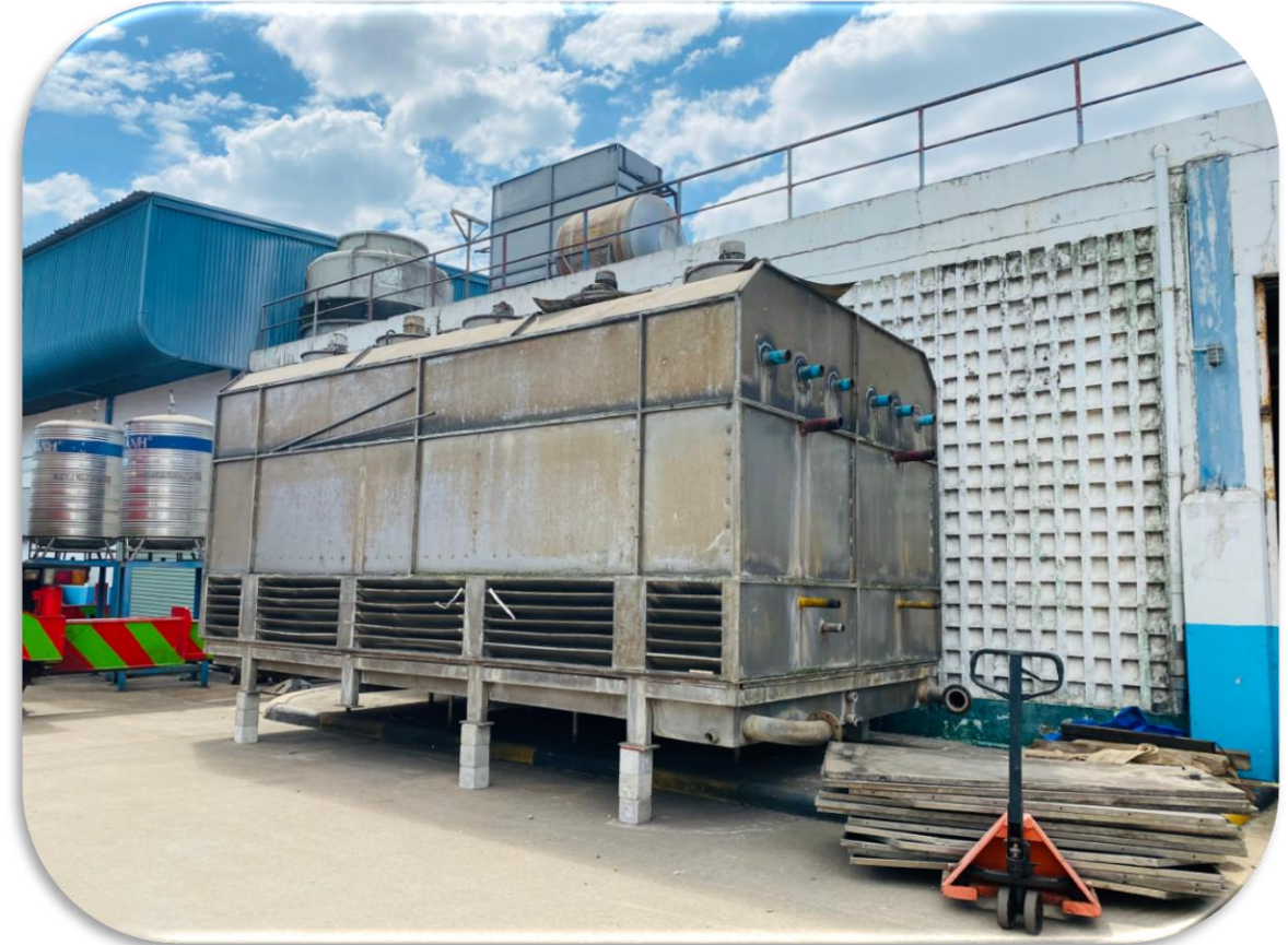
* Cầu lắp 02 bộ tháp giải nhiệt vào vị trí mới.
