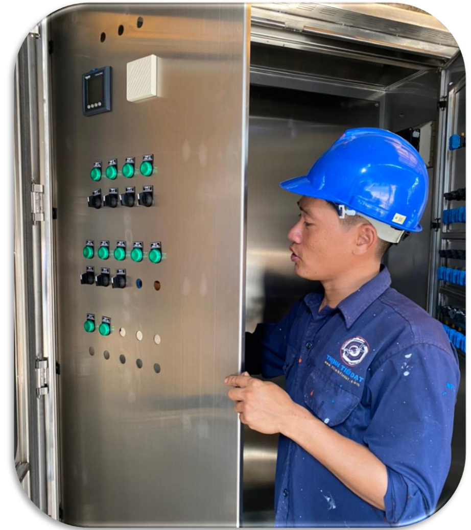
* Cung cấp & lắp đặt tủ điều khiển cho HT tháp giải nhiệt.
