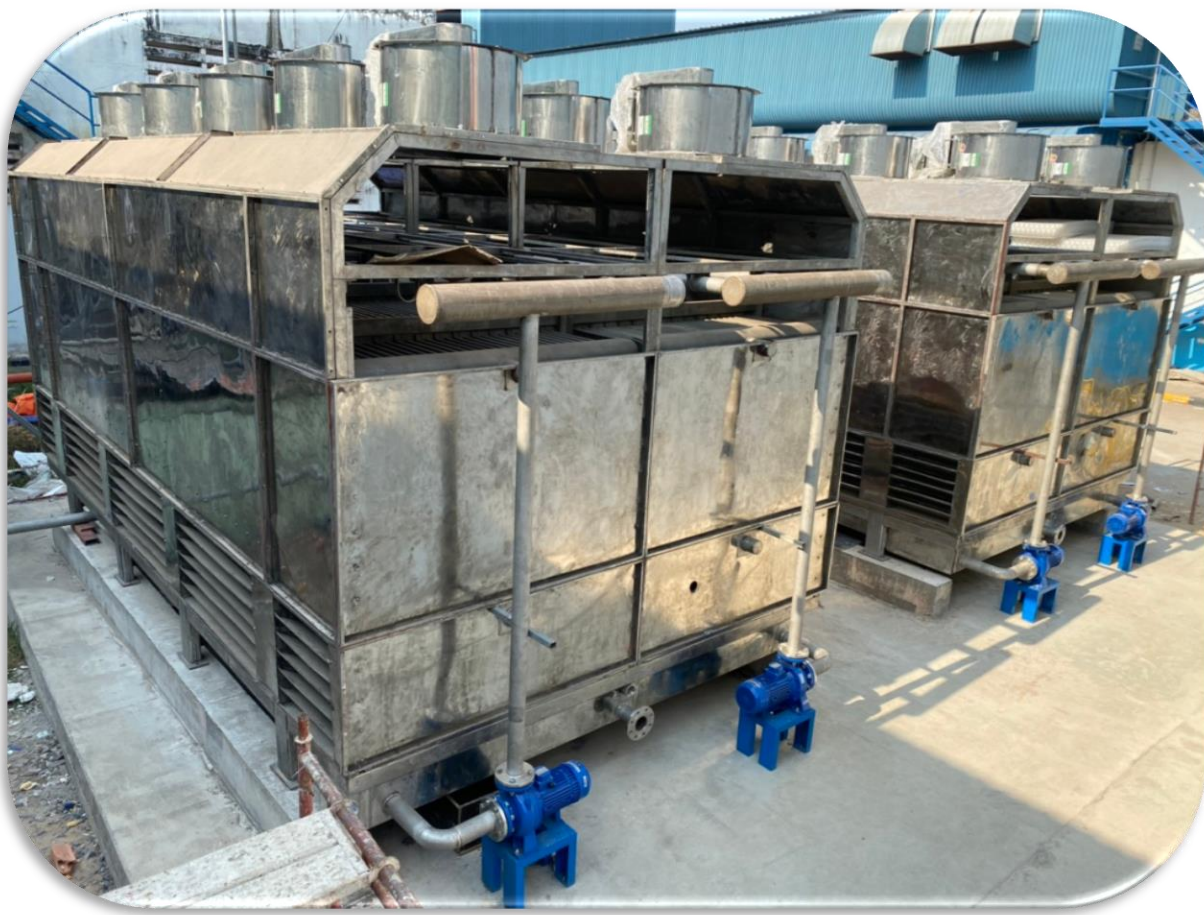
* Lắp hệ thống phun nước cho 02 tháp giải nhiệt.
